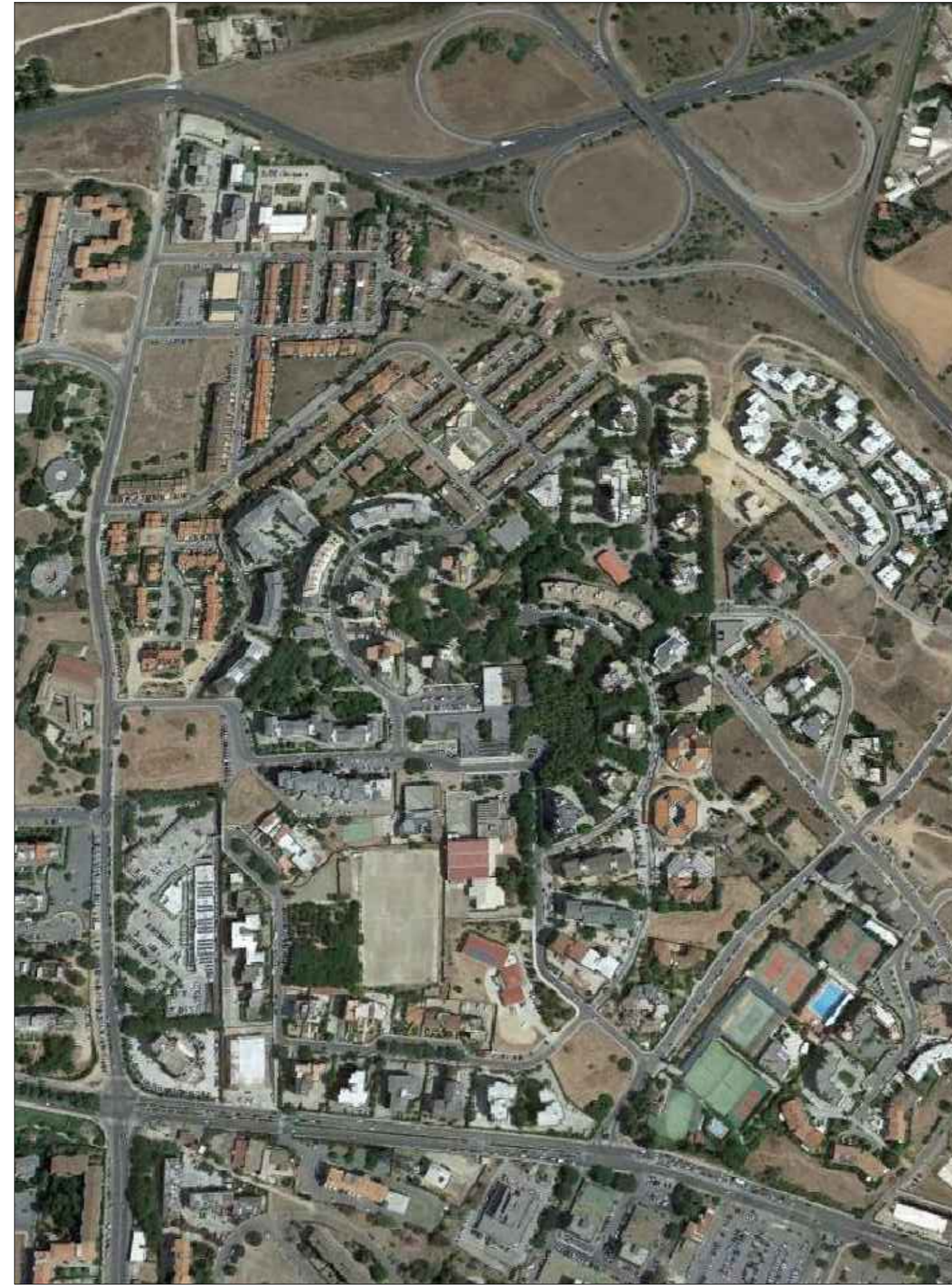
VISTA AEROFOTOGRAMMETRICA Scala 1:5000
